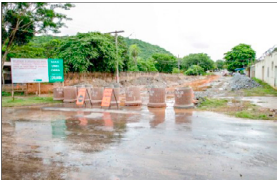
Obra de macrodrenagem no Cristo Redentor
