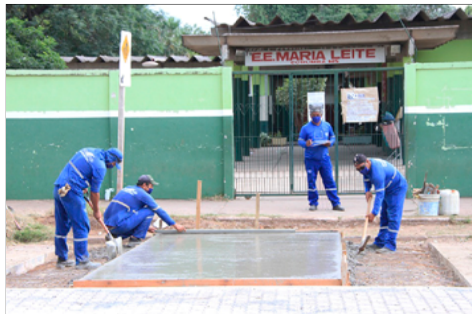
Faixas elevadas foram construídas em frente de duas unidades de ensino
