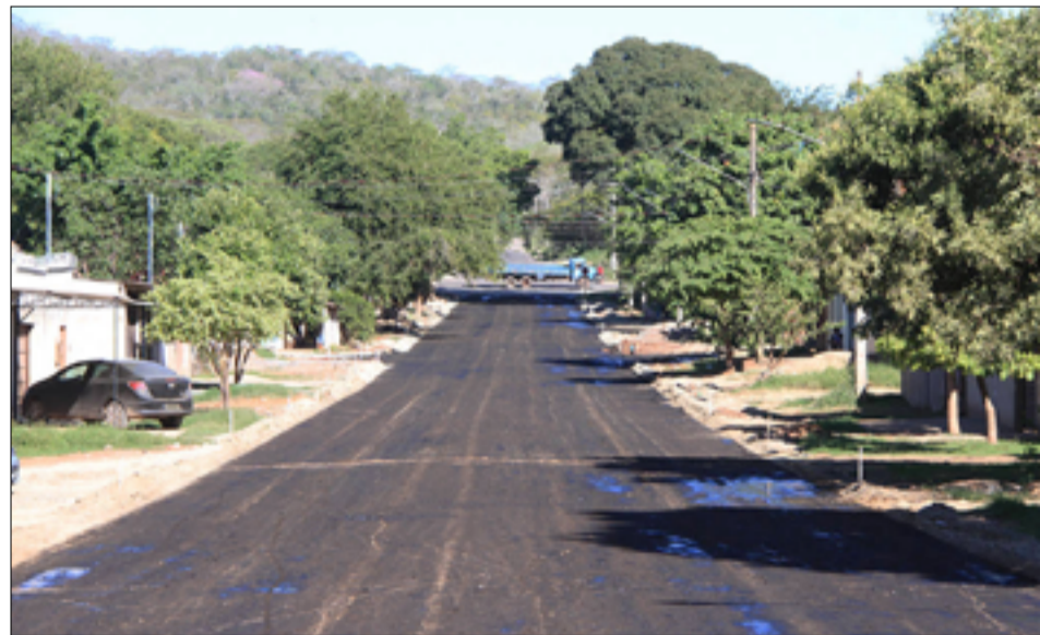
Prefeitura finaliza o serviço na rua Bahia, onde já implantou a drenagem profunda e dá andamento à pavimentação
