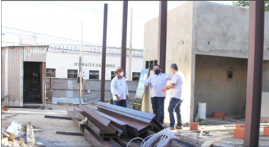
Nova cobertura do terminal rodoviário da Antônio Maria tem investimento de cerca de R$ 800 mil
