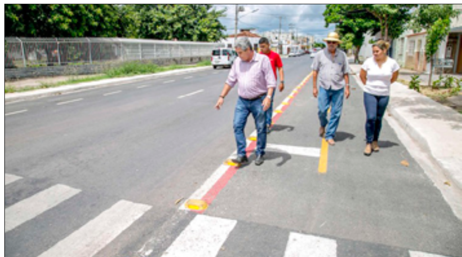
Secretário Ricardo Ametlla durante vistoria nos trechos que precisam ser recuperados
